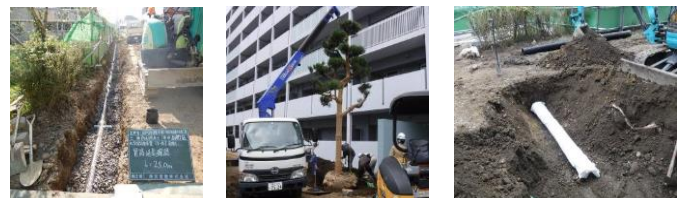
暗渠管及びDOパイプ設置による植栽基盤の整備
