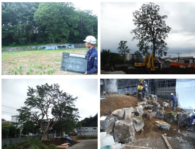
既存状況(左上)、移植状況(右上)、ソメイヨシノの移植(左下)、新設工事(右下)
