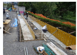
L型擁壁施工状況
