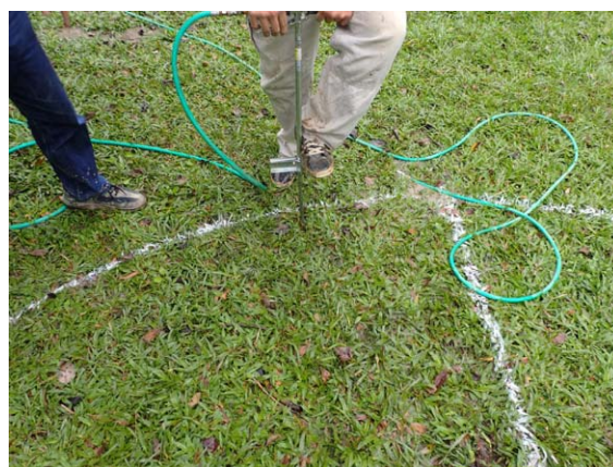
照片 6-9 使用灌注器注入活力劑的施作方法
