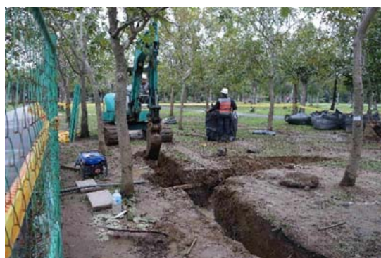
照片 6-3 以重型機具挖掘
