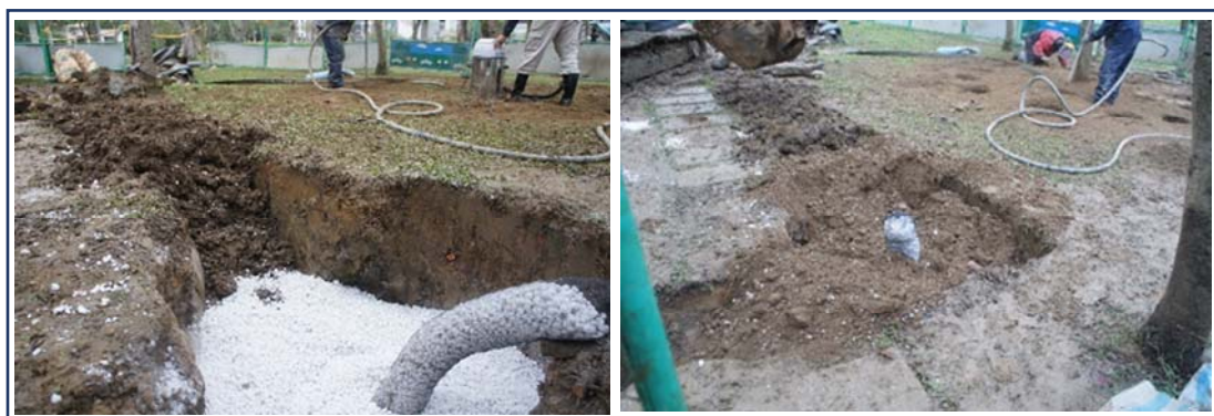
照片 6-7 回填狀況
