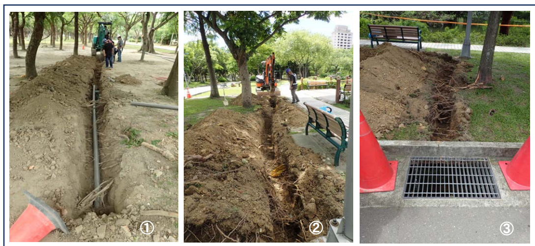
照片 6-10 大安森林公園內埋設管線工程的狀況
