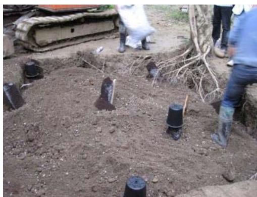
照片 3-3 2014 年土壤改良回填狀況
