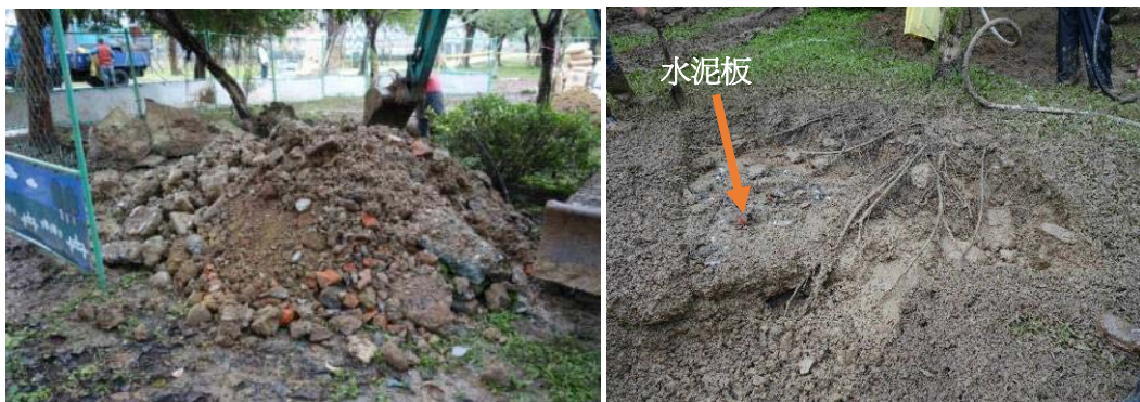
照片 2-7 No.15 榕樹區的瓦礫。埋設了許多建築廢棄物。
