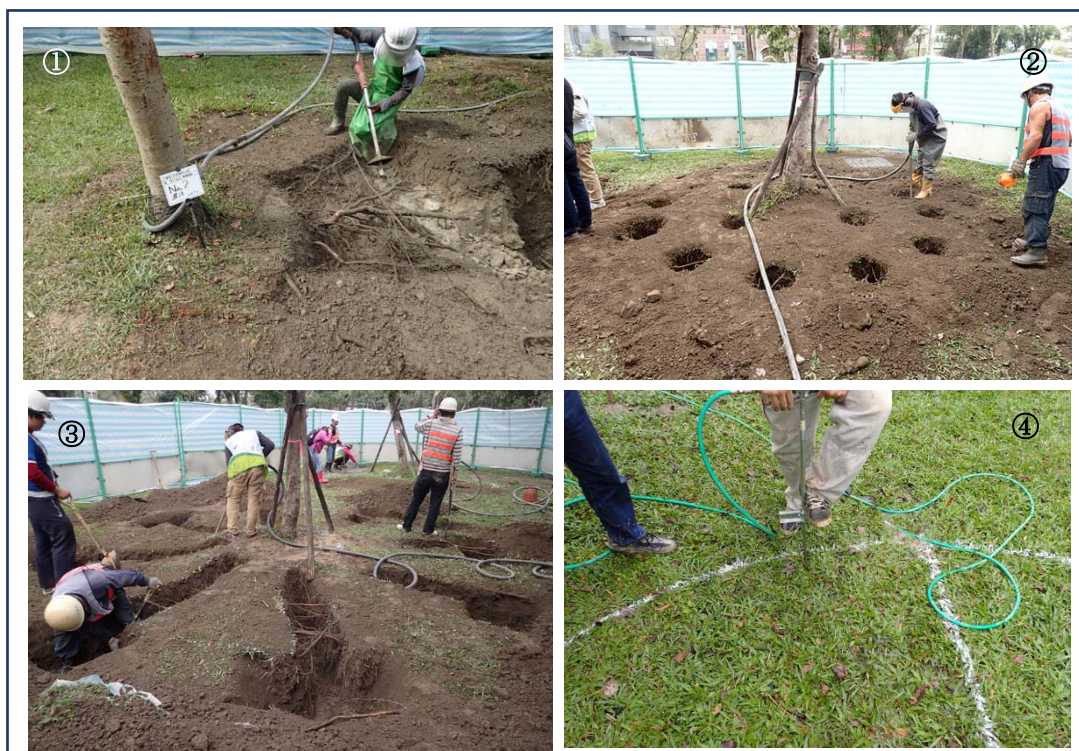
照片 5-15 使用機器的各種改良工法挖掘狀況
