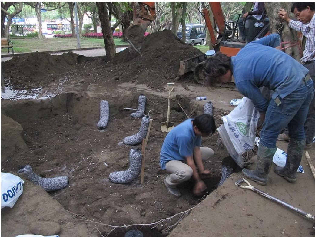
立刻換土作排水及土壤改良
