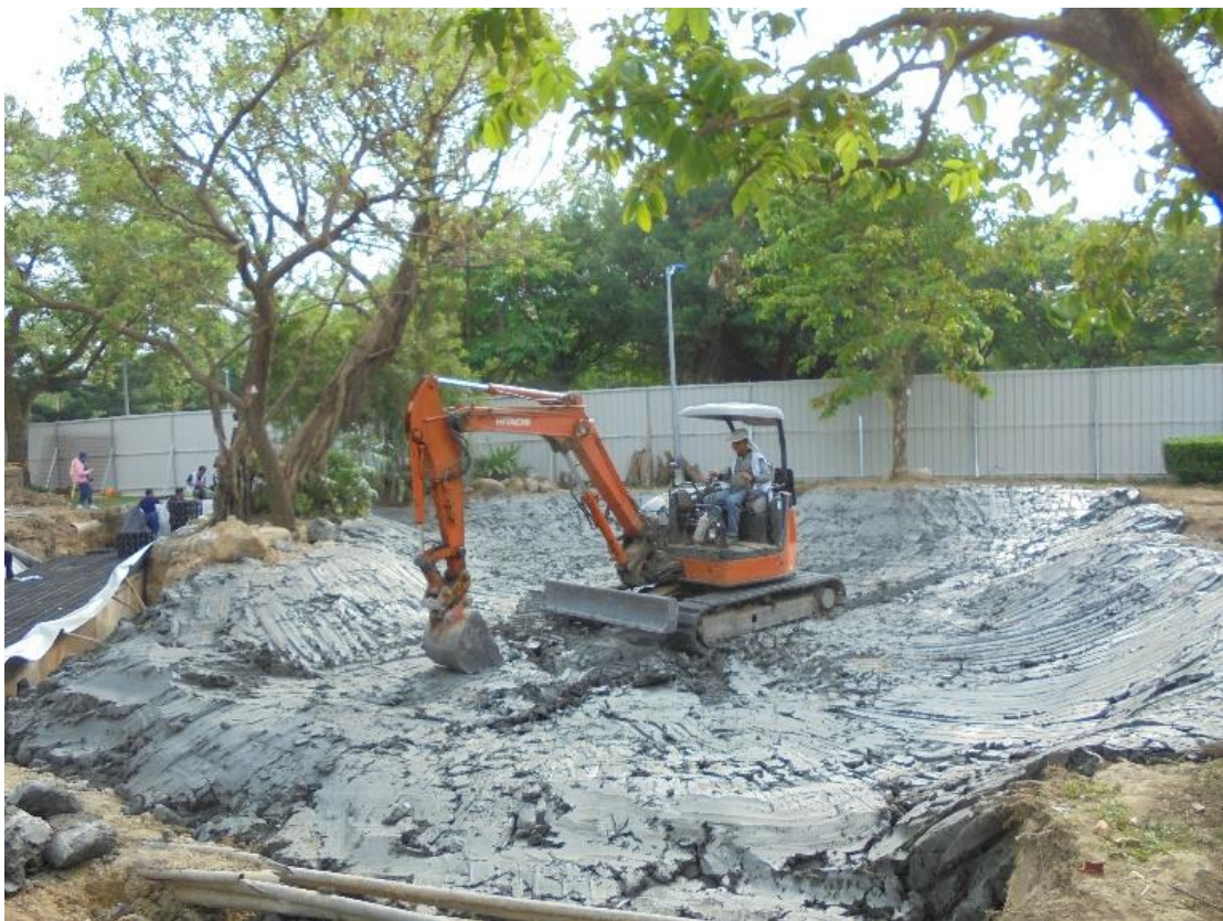
挖開水池鋪上黏土防漏
