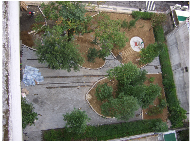
圖 1 錦安公園的透水鋪面、雨水花園基地鳥瞰。
