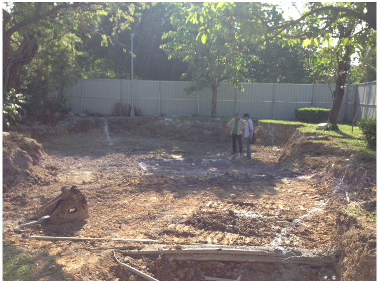
生態池開挖整地
