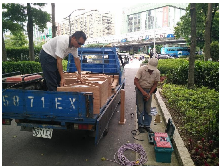
圖二、架設施工過程。
