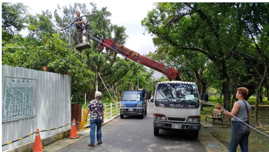
圖 1. 架設巢位監測系統線路
