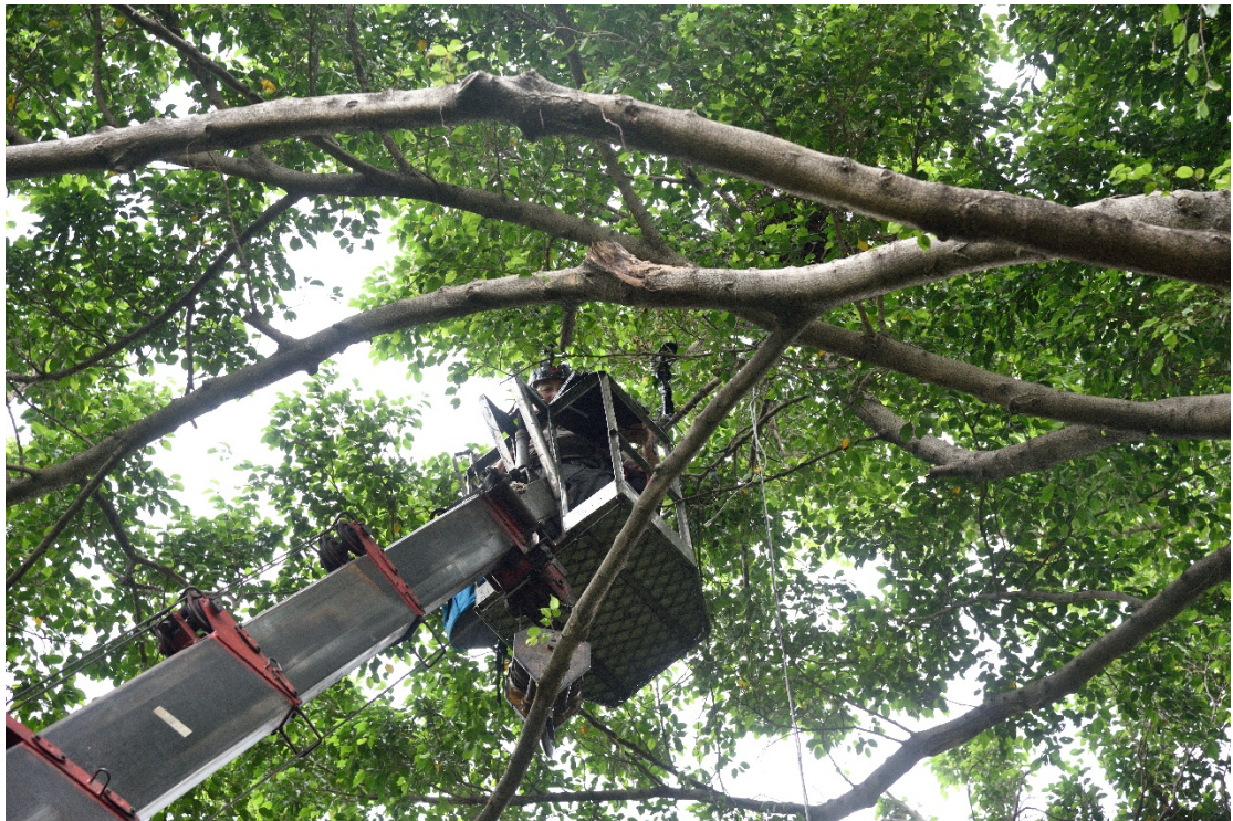
圖 2.架設巢位監測系統線路
