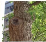
圖五、修剪後切口腐朽速度大於包圍癒合速度。
